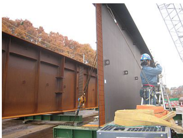
写真 K.22 仙台市の（仮称）ひより台大橋の桁
