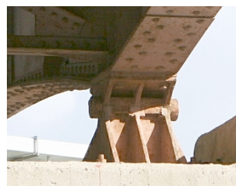
写真 2.4 橋脚天端に載っている支承
