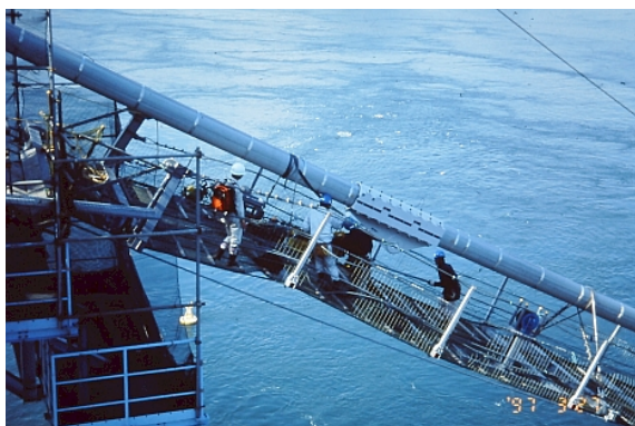
写真 K.13 来島海峡大橋のキャットウォークとハンガーロープ取付部（中沢正利先生撮影）
