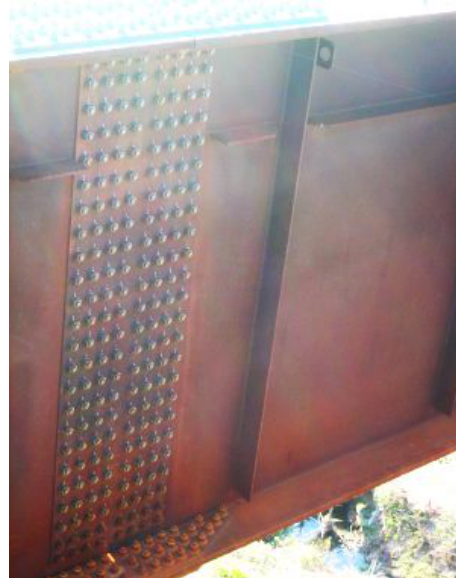
写真 K.26 添接と水平・垂直補剛材
