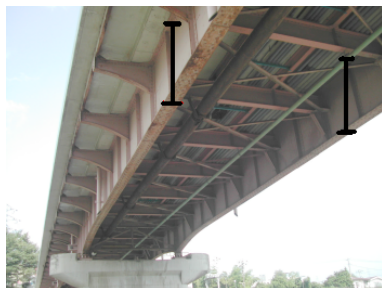
写真 1.5 プレートガーダ橋
