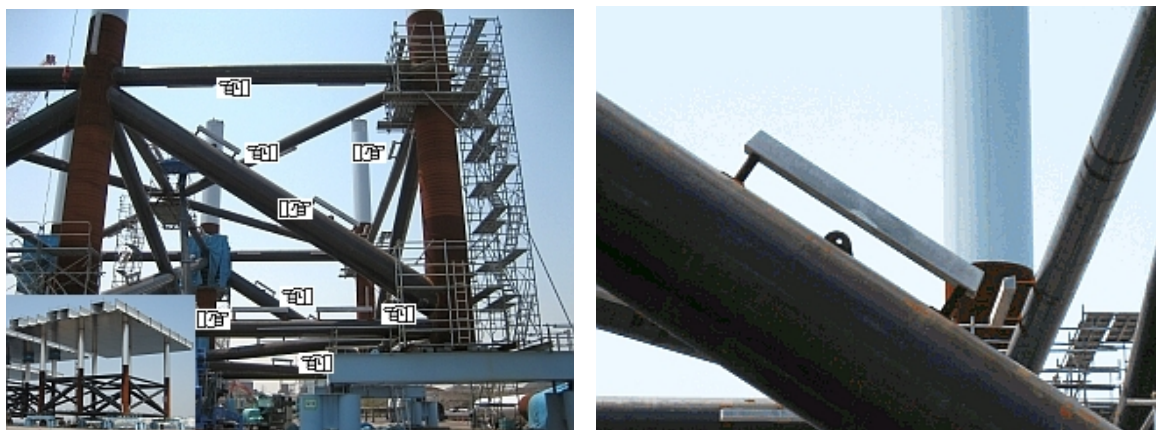
写真 K.2 羽田空港 D 滑走路ジャケット部の犠牲防食 (J 社の製作ヤードにて)
