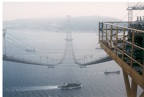
写真 K.12 明石海峡大橋：1994 年（兵庫県南部地震の半年前）の主ケーブル送り出し状況
