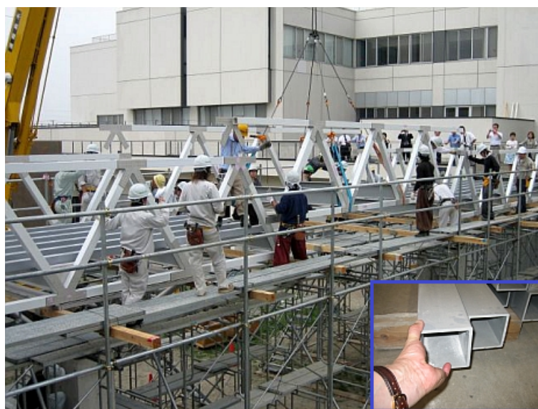
写真 I.1 ものつくり大学内の FRP トラス歩道橋 (学生の研修成果) 2007 年竣工
