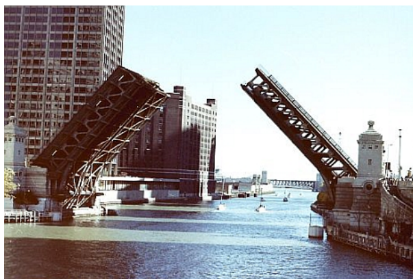
写真 K.1 Chicago River の可動橋 Michigan Avenue Bridge
