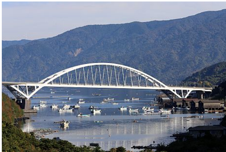
写真 A.1 牛根大橋 対岸の七ツ島で組み立ててクレーン船で桜島半周の海上運搬を経た架設で、気仙沼大島大橋 (p.678) と同じ工法 ( http://kagoshima01.gozaruru.jp/ushineoohasi_unpan/ の写真参照)
