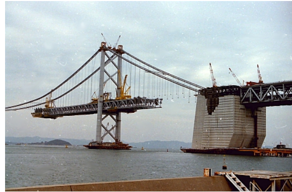
写真 1.12 吊橋 — 南備讃瀬戸大橋
