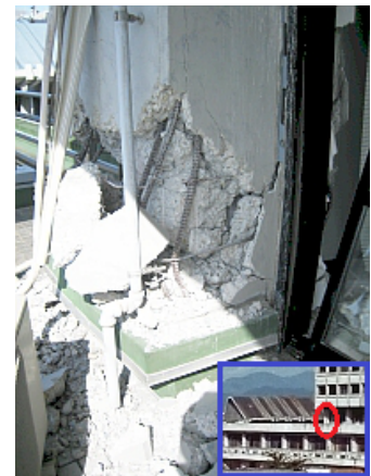
写真 11.2 脆性材料の破壊形態
