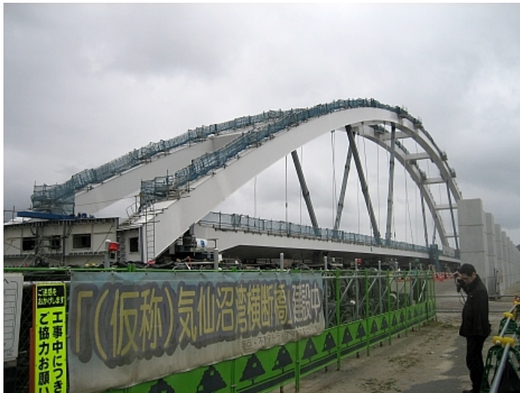
気仙沼大島大橋（仮称：気仙沼湾横断橋）2017年3月ヤードにて
