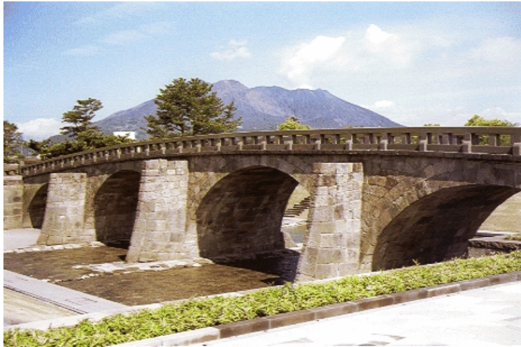
移設後の高麗橋と桜島
