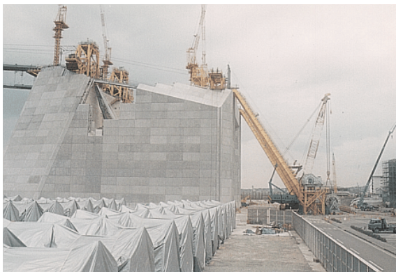
写真 K.12 明石海峡大橋：1994 年（兵庫県南部地震の半年前）の主ケーブル送り出し状況
