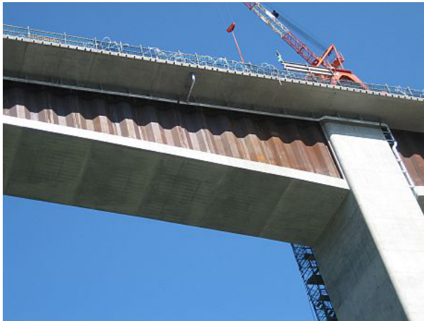
写真 K.3 東北中央自動車道の小川橋
