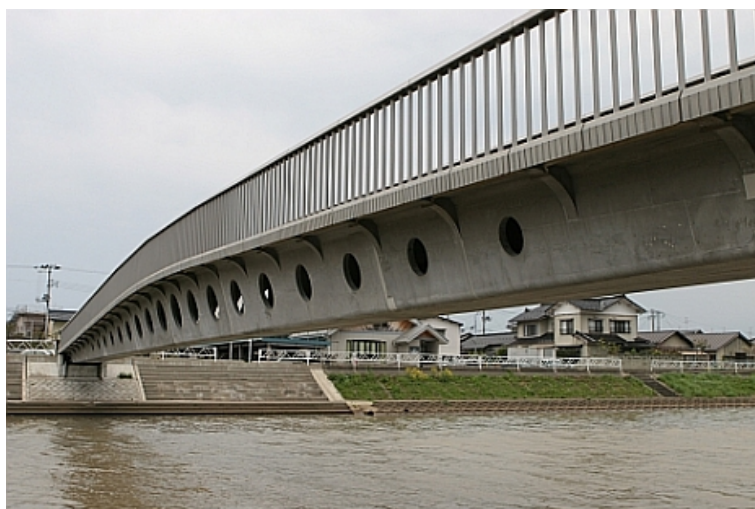
写真 3.5 酒田みらい橋 繊維補強コンクリート外 PC ケーブル歩道橋 2002 年竣工
