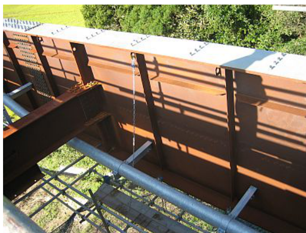
写真 K.19 耐候性鋼の主桁・横桁と内側設置の排水管
