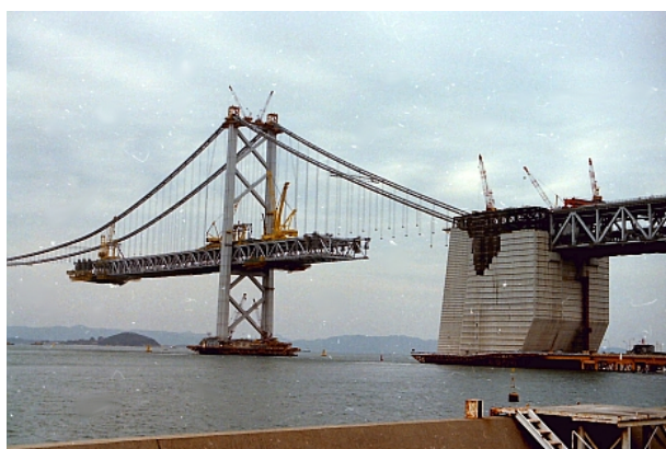
写真 K.14 南備讃瀬戸大橋の坂出側アンカー
