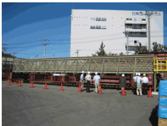
写真 K.6 FRP 橋梁キット製作例
