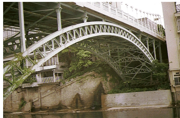
(b) 鋼アーチ橋の例 — 十綱橋 (福島飯坂温泉)
