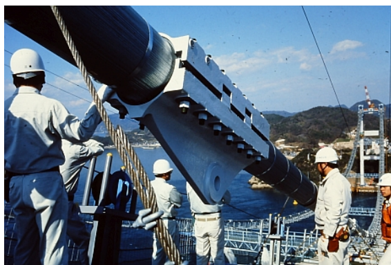
写真 K.13 来島海峡大橋のキャットウォークとハンガーロープ取付部（中沢正利先生撮影）
