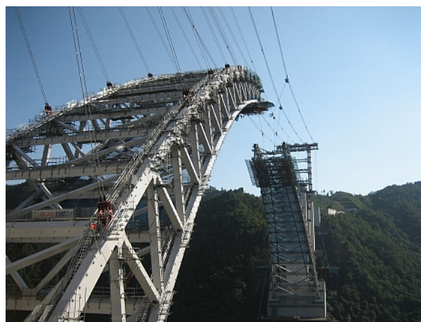
写真 K.10 三原市の広島空港大橋（広島スカイアーチ）
